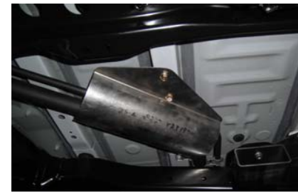
燃料パイプ遮熱版取り付け画像
